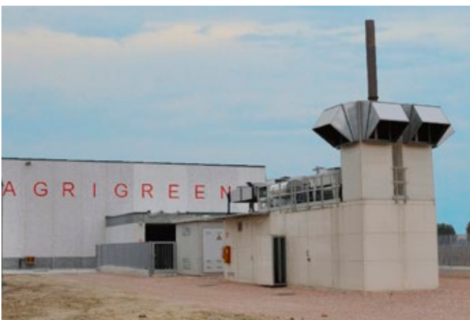
Azienda Agricola Agrigreen - Rivarolo del Re, Italie Digestion anaérobie: 1 MWe - 1 MWt
