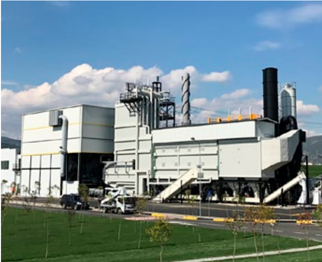
Albtek Energy Shpk - Elbasan, Albanie Incinérateur pour ordures ménagères: 150t/j – 2,85MWe & 12MWt
